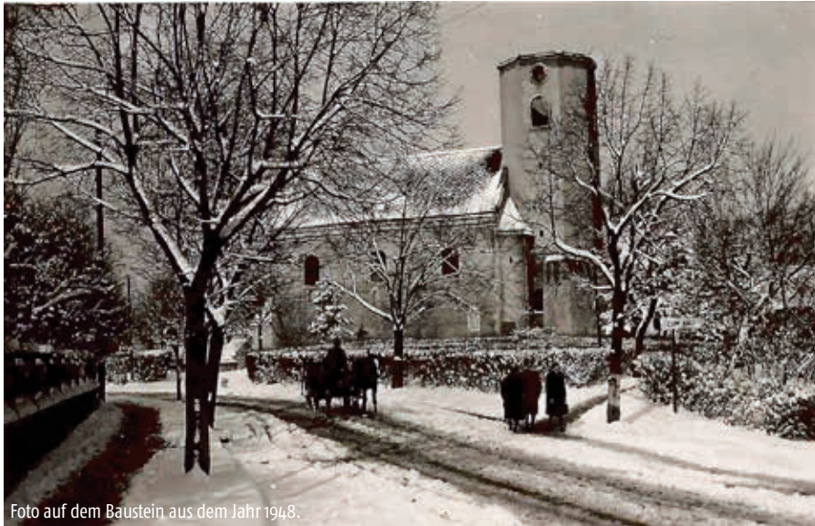
Foto auf dem Baustein aus dem Jahr 1948.
